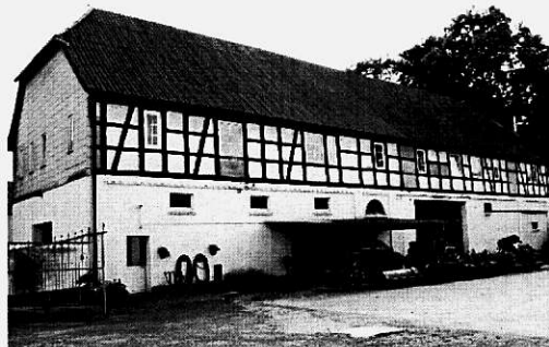
Ehemaliger Pferde- und Schweinestall
